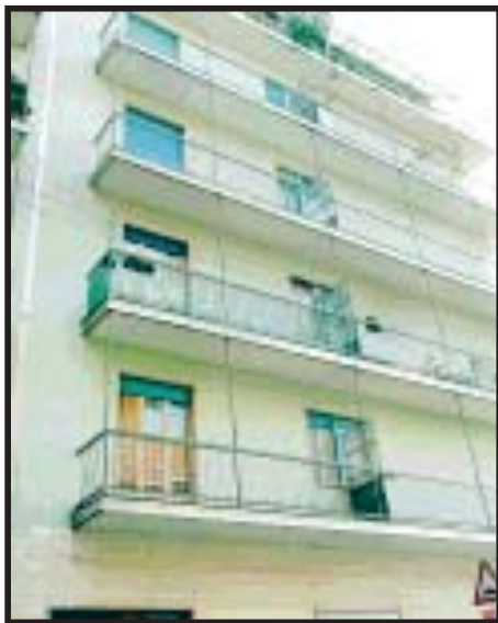
La palazzina di via Vandalino dove è successo l'incidente
